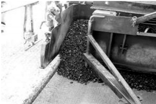
图 3 下面层拼接缝在 1、2 车道分界线处且厚度大于 7 cm 时在铣刨面上走雪橇
