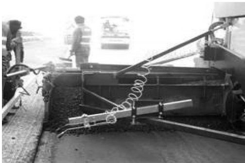
图 2 下面层拼接缝在 2 车道内且台阶厚度为 6 cm 时在铣刨面上按设计标高控制走铝合金梁
